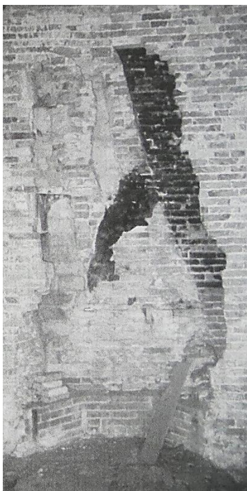
Afb. 5. Een donker rookkanaal rechts en een warme luchtkanaal parallel links ervan en afb. 6. Een warme lucht inlaatopening met rooster en schuif (rechts).
