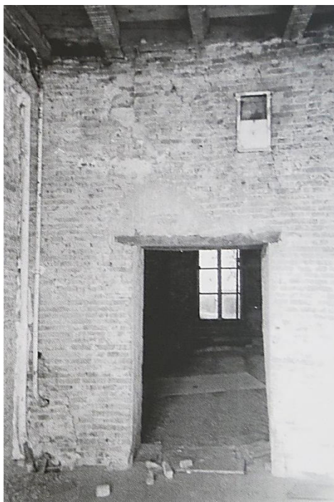
Afb. 5. Een donker rookkanaal rechts en een warme luchtkanaal parallel links ervan en afb. 6. Een warme lucht inlaatopening met rooster en schuif (rechts).
