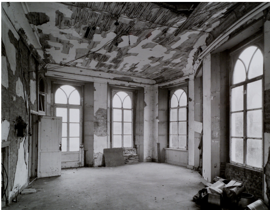
Afb. 16. De orangerie in 1959. De onderdorpels van de ramen aan zuidzijde (rechts) lagen oorspronkelijk op of net boven het vloerniveau. 21
