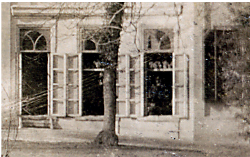
Afb. 15. Zuidzijde van de vleugel met de orangerie. Met drie raamassen in het gebogen vleugeldeel, met aan binnenzijde luiken en met naar buiten uitslaande vensters. Het linker raam waar een houten trap voor staat fungeerde als toegang vanuit de tuin. Bij de twee ramen zijn bovenin planken met potten en planten zichtbaar. Uitsnede foto uit circa 1905. 20
