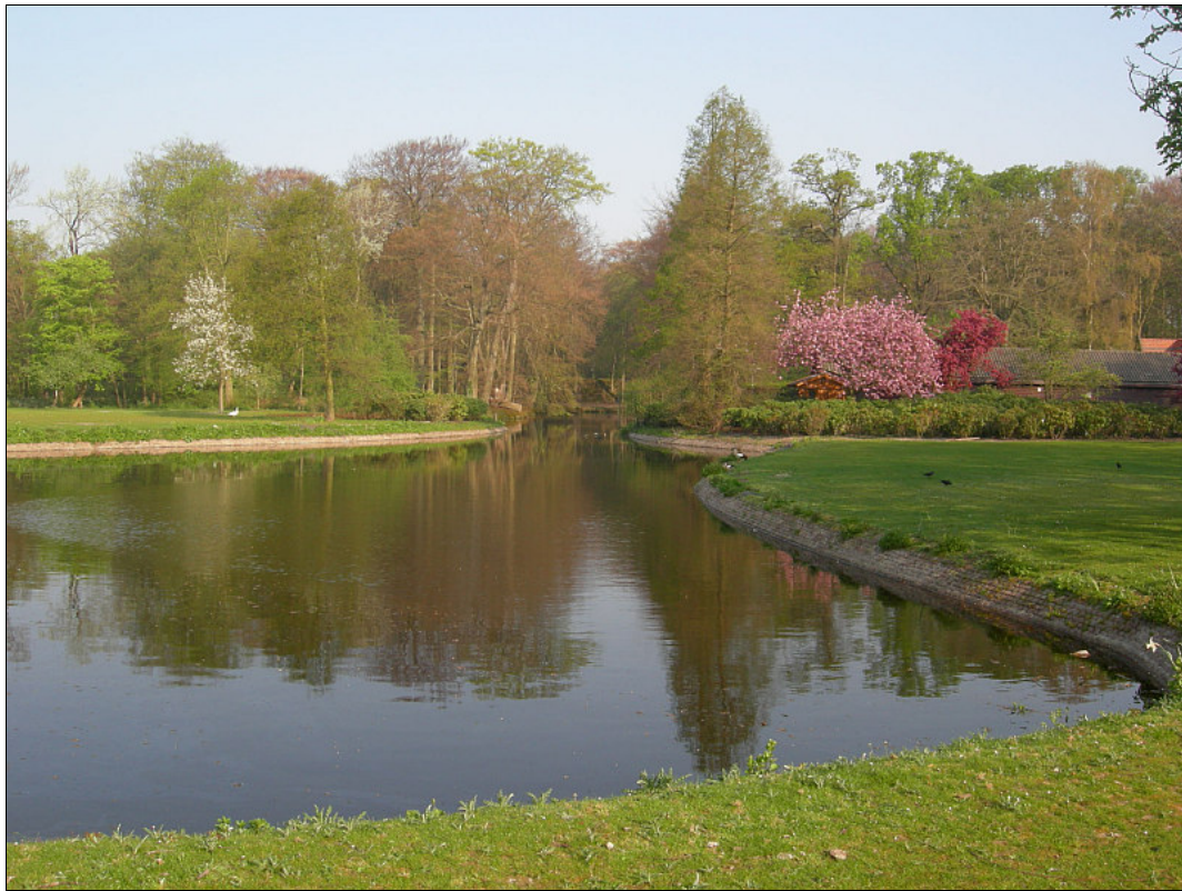
Fase 1,2,3 Zelfde waterpartij als boven opnieuw beschoeid, hier kijkend loodrecht op de zichtas
